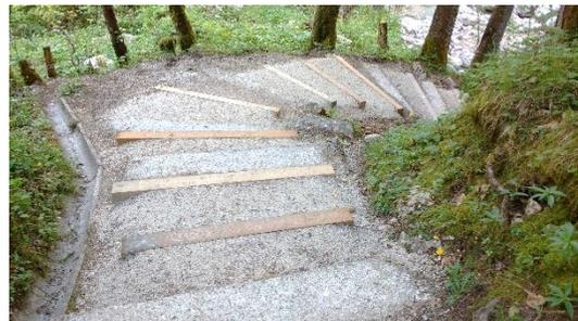
Für all diese Arbeiten waren 145 Arbeitsstunden und ca. 18 m<sup>3</sup> Wegschotter notwendig, auch wurden zusätzlich 6 Wasserrinnen eingebaut.
